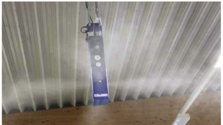
Ist die Luft in der Werkstatt zu trocken, versprüht der Felder-Druckluftbefeuchter feine Wassertropfchen und befeuchtet bis zu 2500 Kubikmeter Raumluft.
