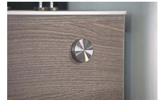
Edelstahlkappen verdecken die Schrauben
