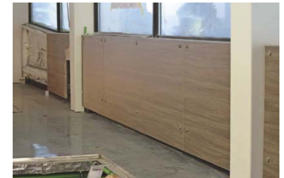
Die demontierbaren Elemente sind stumpf gestoßen
