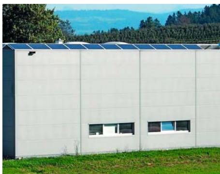
/ Das Dach der Halle ist komplett mit Fotovoltaik-elementen bestückt. Stromrechnung: Null Euro und die Amortisationszeit beträgt nur sieben Jahre.
